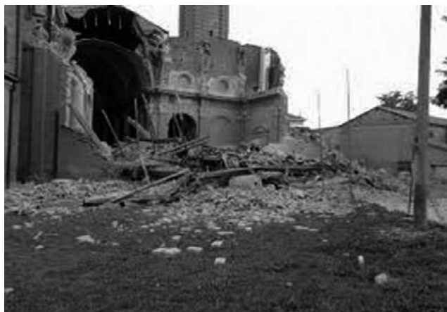
La distruzione causata dal terremoto in Emilia
