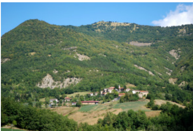
Trevignano, veduta panoramica
